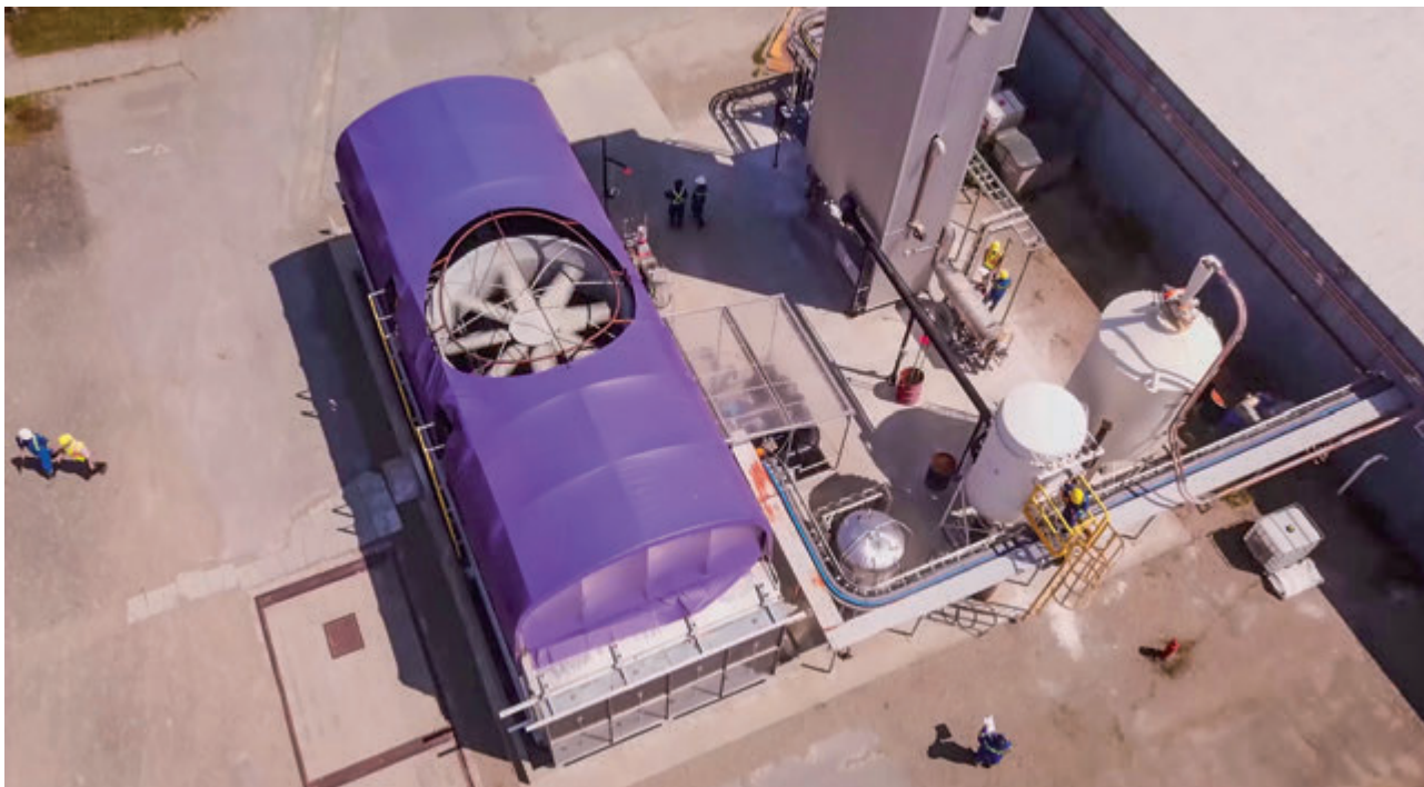
Pilotanlage zur direkten Luftkohlenstoffabscheidung von Carbon Engineering
